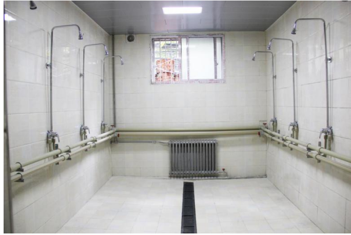
学生男女浴室维修后照片
